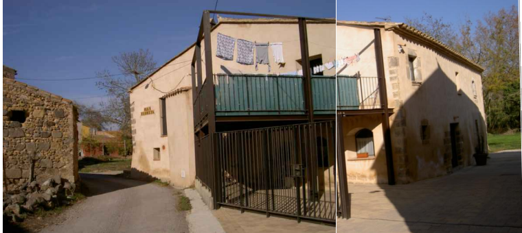
façana interior parcel.la i relació amb vialitat - cos principal
